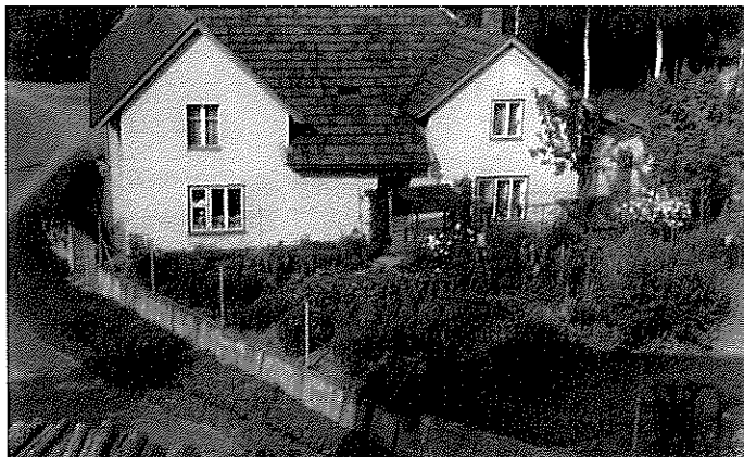
Přestavěný dům v r. 1963 pohled od západu
