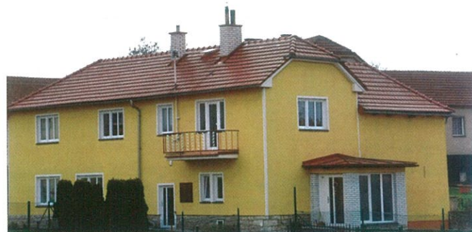
čp. 140 po přestavbě r. 1960, výměna oken a stř. tašek r. 2010
