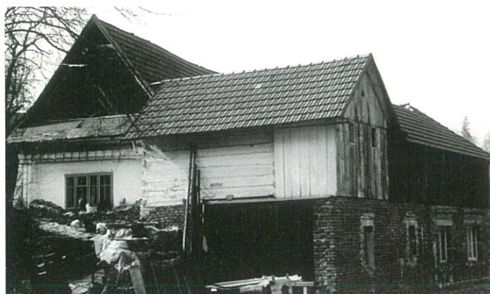
Původní chalupa v začátcích přestavby
