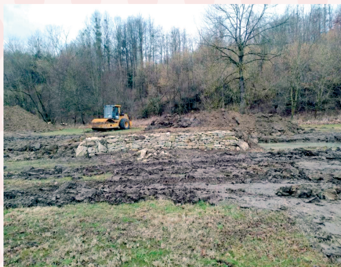
výstavba úkrytu pro živočichy
