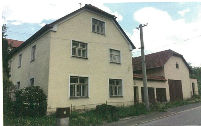
Chalupa č. 210 pohled od jihovýchodu
