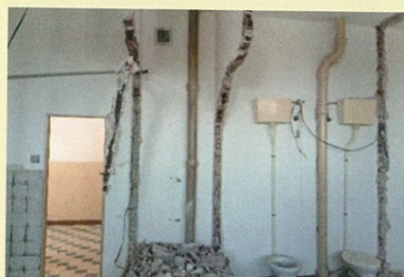
foto z průběhu rekonstrukce
