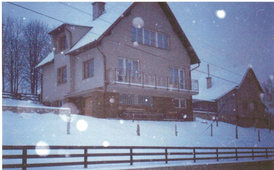
Současný stav čp. 533
