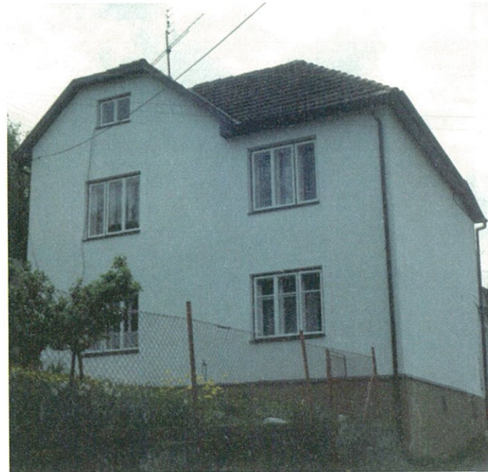
čp. 191 po přestavbě v r. 1960
