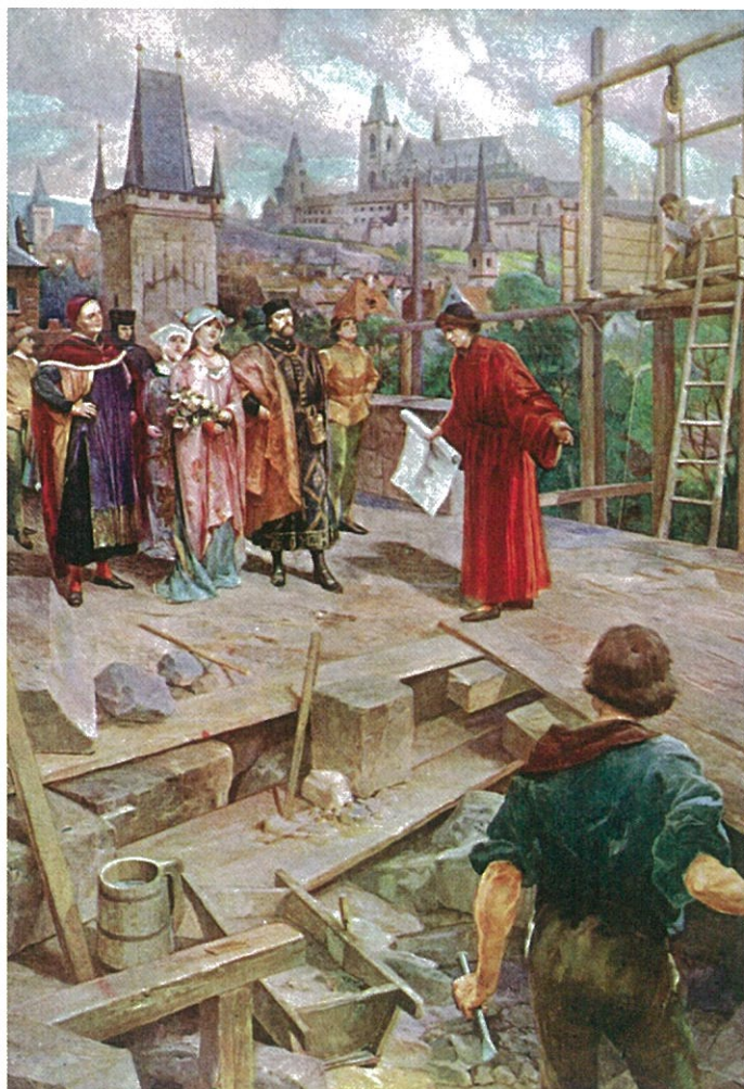
Karel IV. na prohlídce stavby kamenného mostu.
