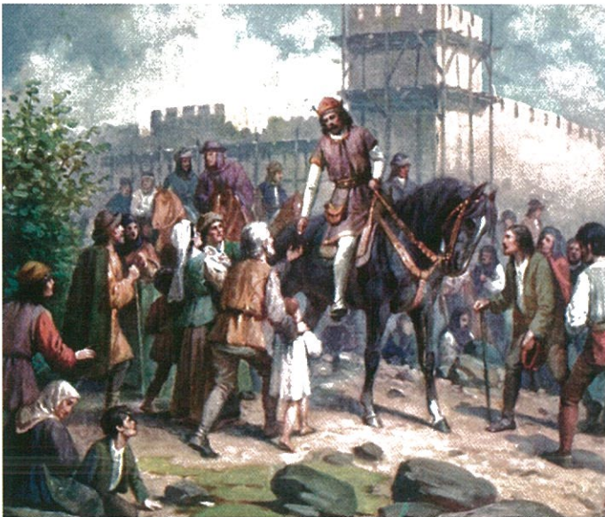
Stavba Hladové zdi.
