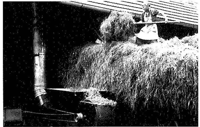
Skládání sena senometem. Senomet nahradil mnoho lidí, kteří byli potřební k dopravě nebo urovňování na patře.
