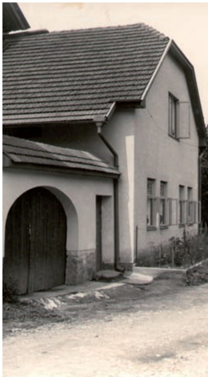
Přestavba v r. 1948
